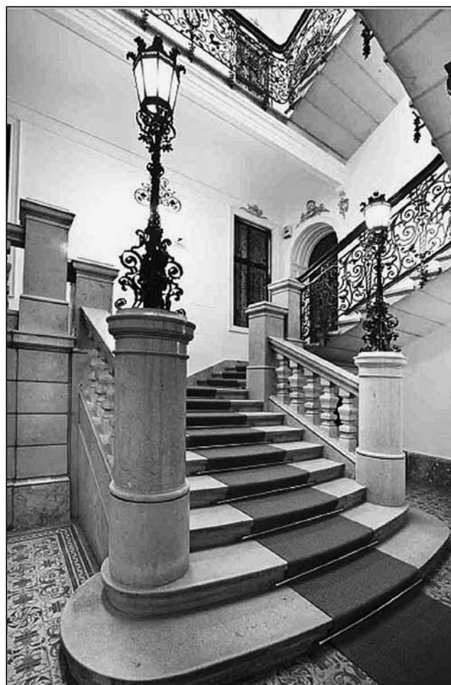
Schodiště obytného domu Herzmanských na Lindengasse čp. 10 (Zdroj: www.jpi.at ).
