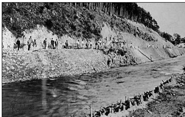
Stavba železniční trati Suchdol n. O. – Budišov n. B. u mankovickeho mostu, 1891. Archiv muzejního spolku Rolleder, o. p. s.
